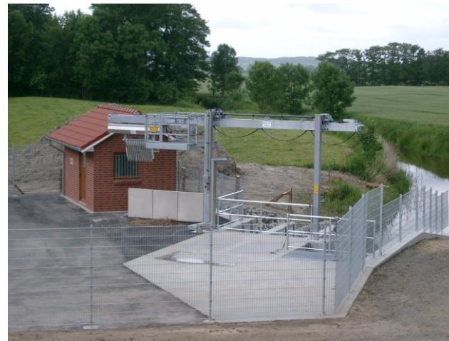
Schöpfwerk Braaker Schleusenfleth nach Neubau 2010
