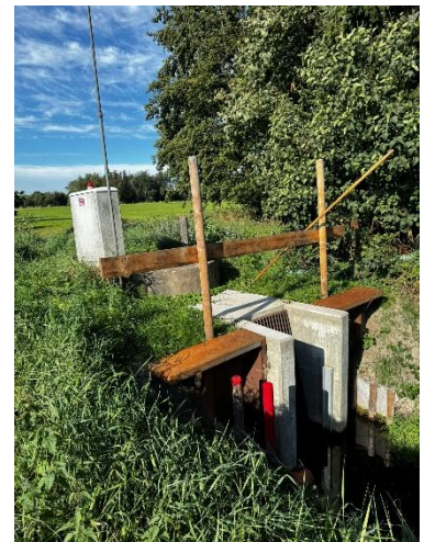
Polderschöpfwerk Seekanal Polder 9
